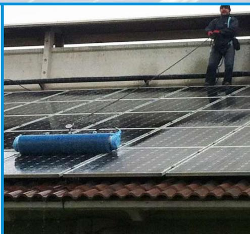
Questo nuovo sistema sfrutta la pressione dell'acqua per generare in modo idrocinetico la rotazione e quindi l'effetto pulente delle setole, studiate appositamente per i pannelli fotovoltaici, associati all'azione dell'acqua demineralizzata (pura al 100%) porta ad una doppia azione che ne permette un lavaggio ottimale.
